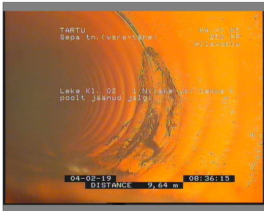
Pilt: K4_K5_6_083617_3_A.JPG, 00:01:13 9,64m, Leke Kl. 02 , 1 Niiske või lekke poolt jäänud jälgi
