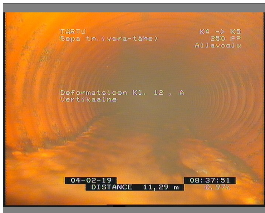
Pilt: K4_K5_6_083753_4_A.JPG, 00:01:47 11,29m, Deformatsioon Kl. 12 , A Vertikaalne
