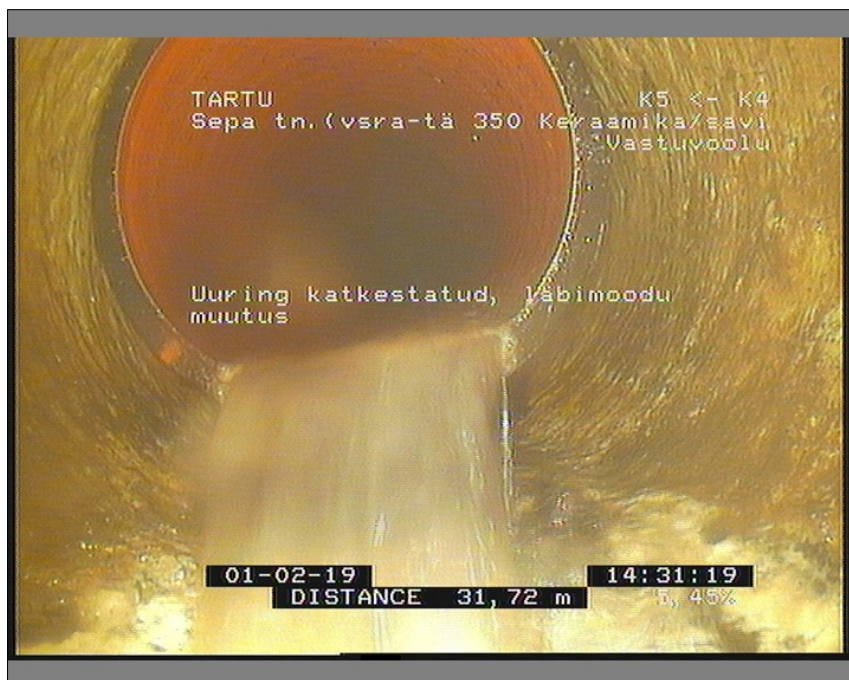
Pilt: K4_K5_7_143120_6_A.JPG, 00:02:35 31,72m, Uuring katkestatud / läbimõõdu muutus
