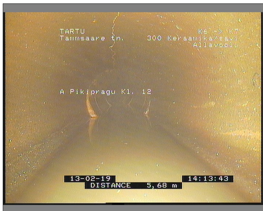
Pilt: K6_K7_6_141358_2_A.JPG, 00:00:17 5,68m, A Pikipragu Kl. 12
