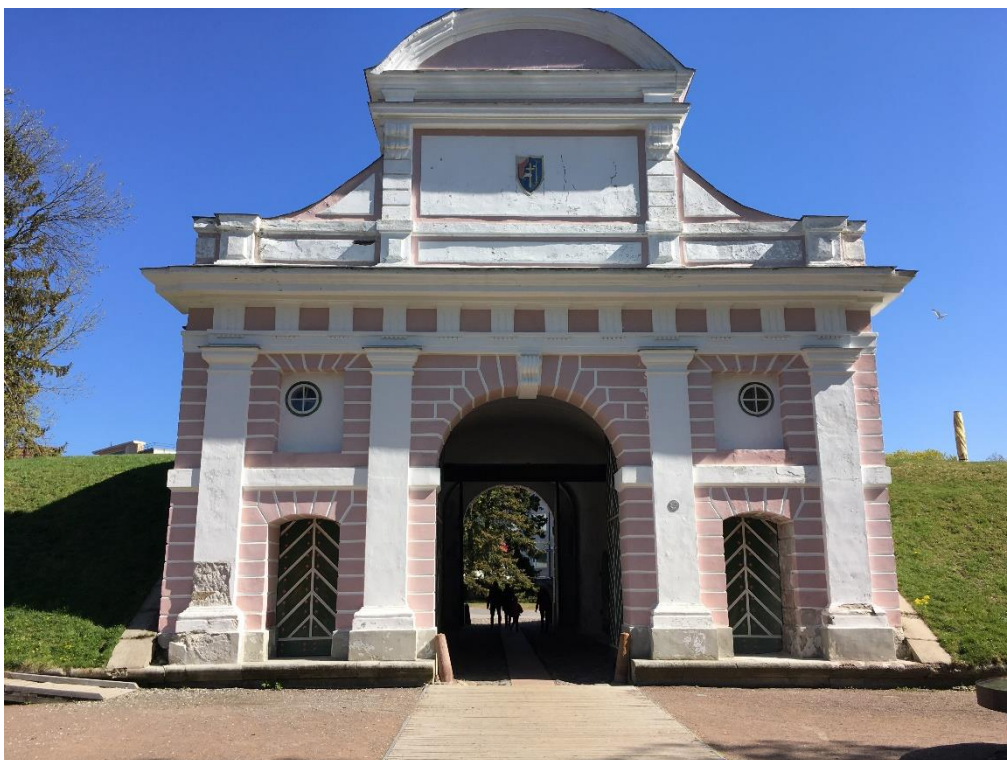
Foto 1 Vaade restaureeritava Tallinna värava mere poolsele fassaadile.
