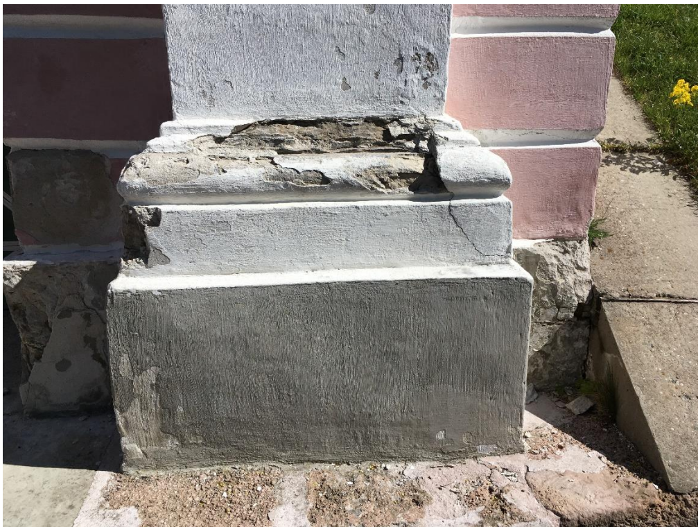
Foto 4 Krohvikaad merepoolse fassaadi parema piilari alusel.
