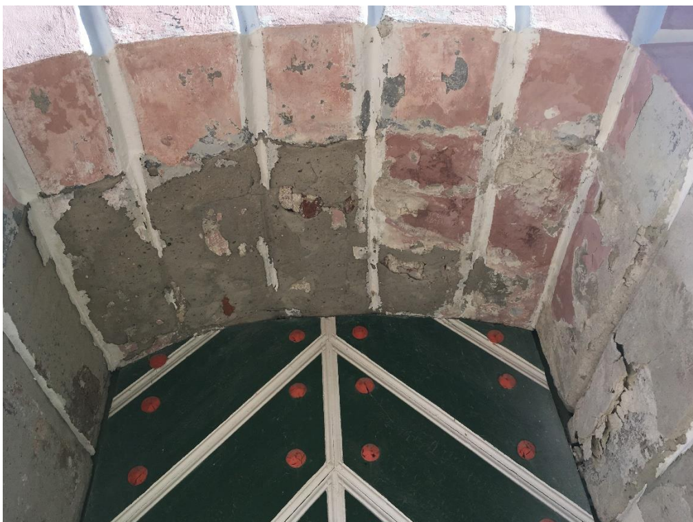
Foto 5 Krohvi ja värvi irdumine merepoolse fassaadi paremas ukseavas.
