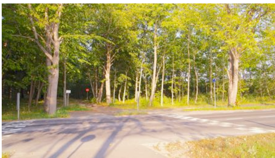
Foto 7: Vaade mõisaparki kulgevast mahasõidust, mis kuulub sulgemisele. See ei ole olnud aktiivses kasutuses ka täna. Parki pääs takistavad kaks suuremat kivi ja sissesõit on keelatud ka liiklusemärgiga, samas on kergliiklustee ületuskoha kõrval olemas asfalteeritud mahasõit. Foto paremas servas paikneb tõstetud ülekäigurada.
