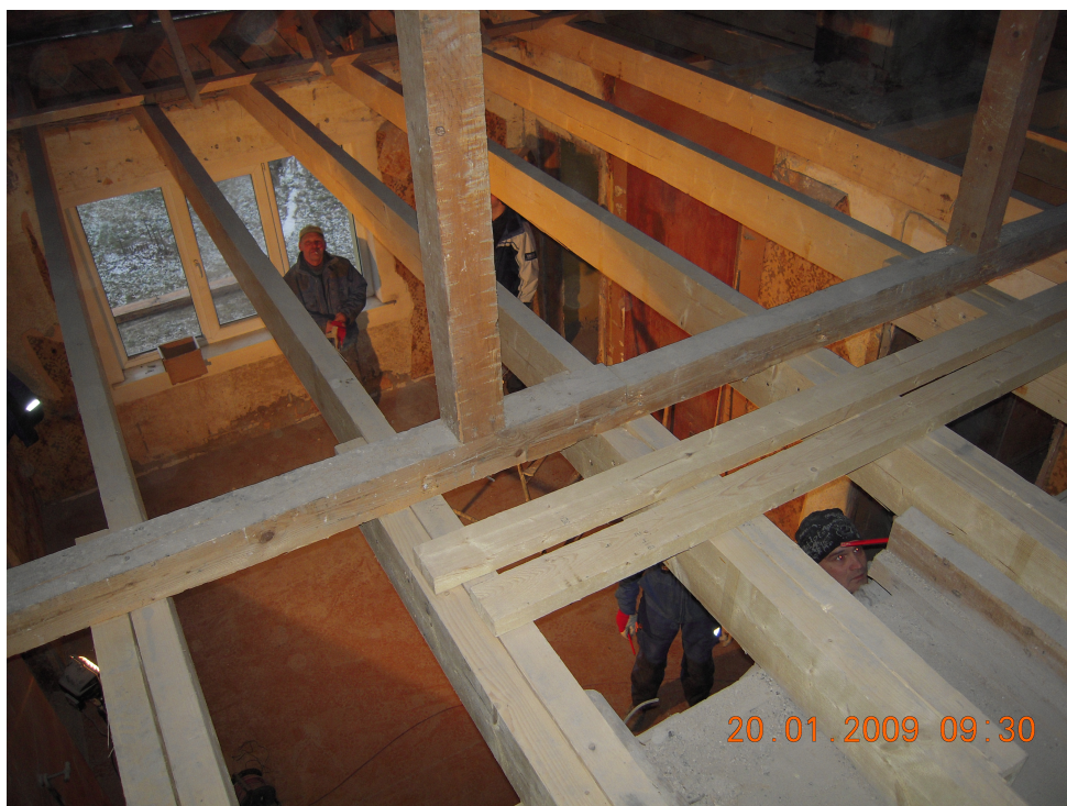
Vahelae konstruktsioonid (pildistatud 2009 teostatud remondi ajal)
