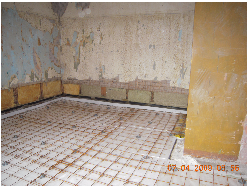
Põranda soojustamine (pildistatud 2009 teostatud remondi ajal)
