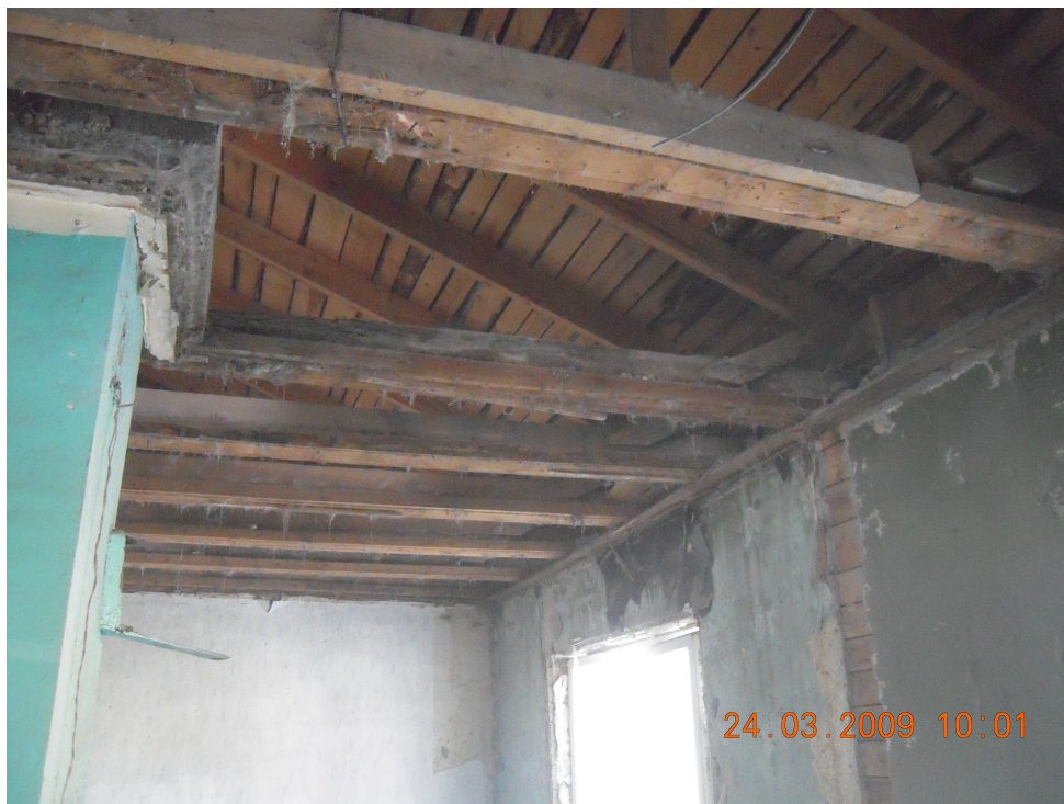
Vahelae konstruktsioonid (pildistatud 2009 teostatud remondi ajal)
