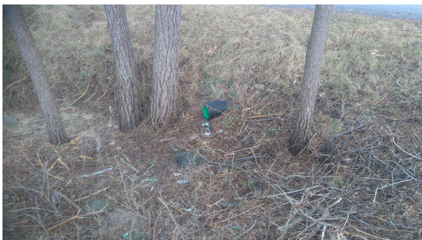
Foto 8. Lohusalu tee L3 kinnistul paiknev sademeveetruup
