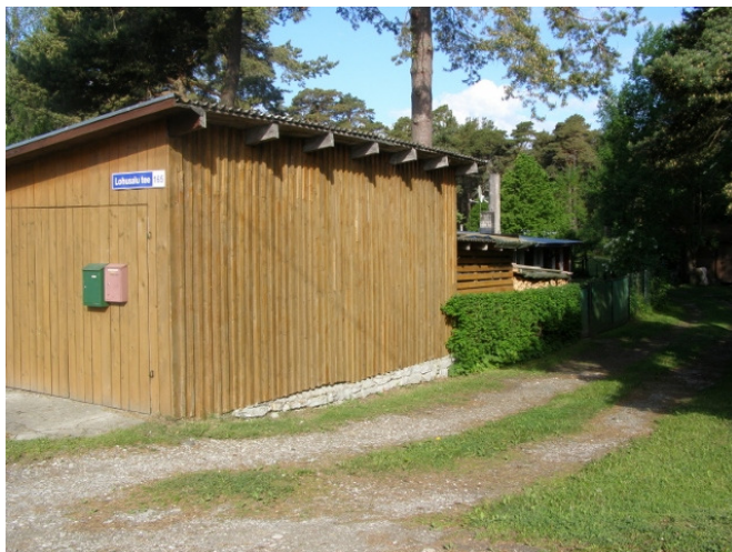
Foto 3. Vaade Lohusalu tee 165 ja 167 kinnistul paiknevatele hoonetele
