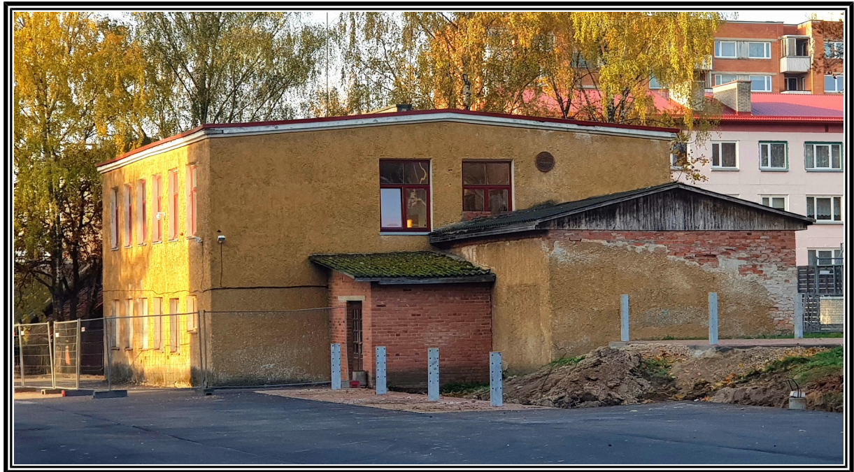
Foto 1. Vaade hoone peasissepääsu suunas.
