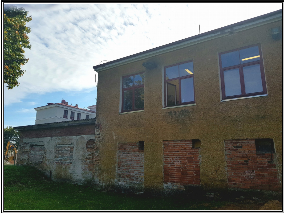
Foto 4. Vaade hoone tagant. Alumise korruse aknad on kinni müüritud. Taastada alumise korruse aknad analoogselt II korruse akendega. Hoone fassaad korrigeerida ning üle krohvida
