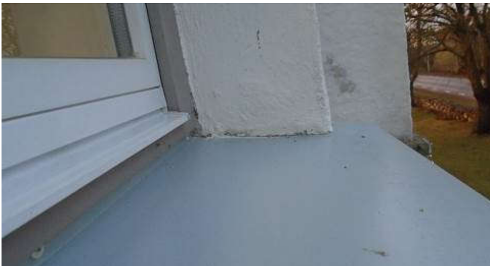
Foto: akende palede krohviikiht ei ole aluspinnalt lahti
