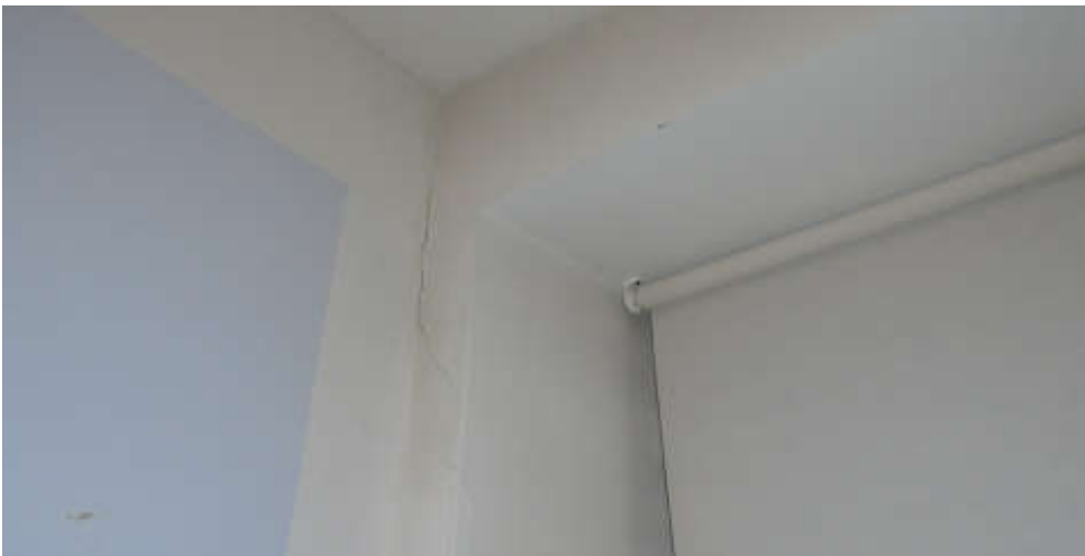
Foto: akende paletes on pragusid, mis ei ole ohtlikud ega varisemisohtlikud
