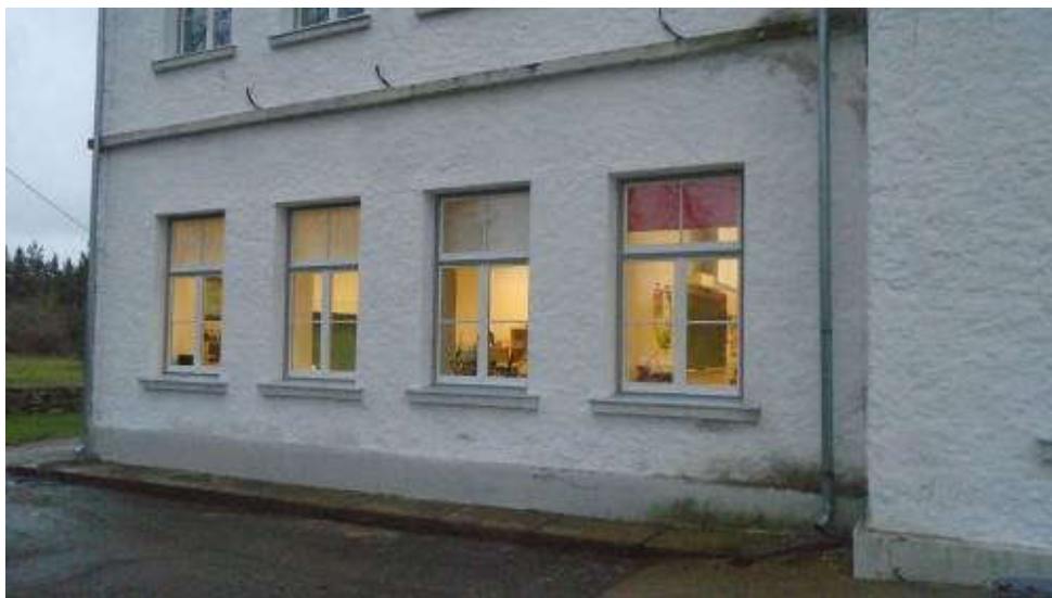
Foto: lubikrohvist fassaadid on üldiselt rahuldavas seisus. Värvkate kahjustatud
