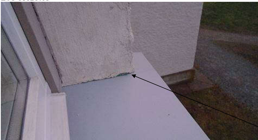
Foto: akende palede krohvikihit ei ole aluspinnalt lahti, täita pleki vuugid
