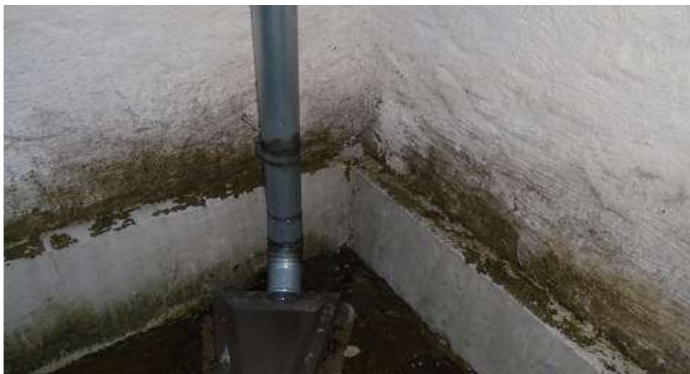
Foto: fassaadi krohvikihit on vaja survepesuga puhastada ja värvida lubivärviga
