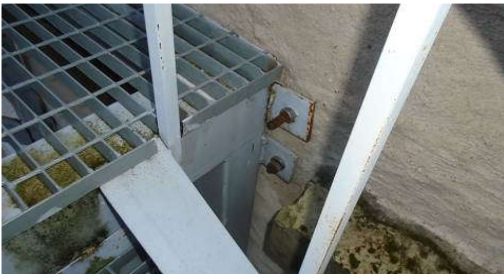
Foto: evakuatsioonitrepi metallidetailid värvida
