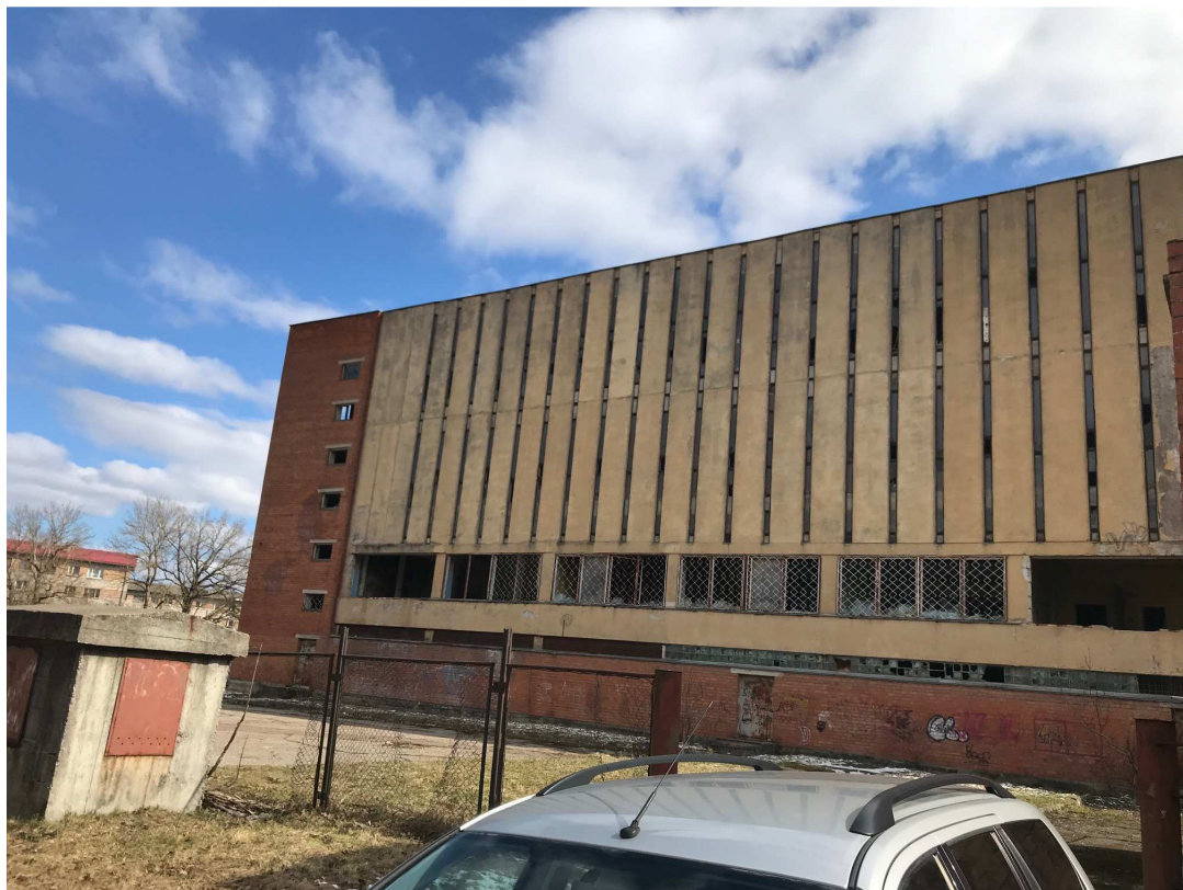
Vaade lammutatavale hoonele.
