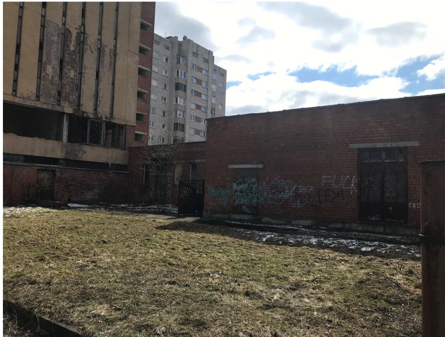
Vaade lammutatavale hoonele.
