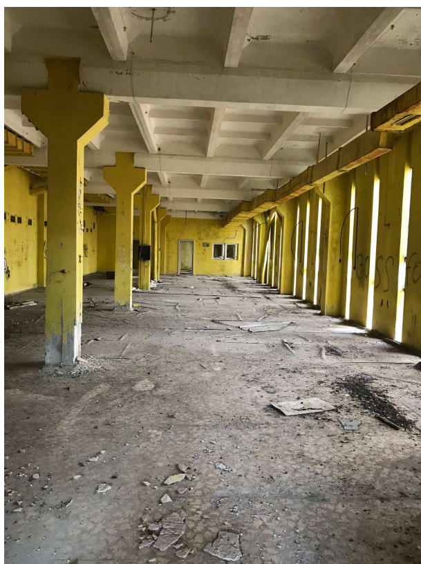
Vaade lammutatavale hoonele seest.
