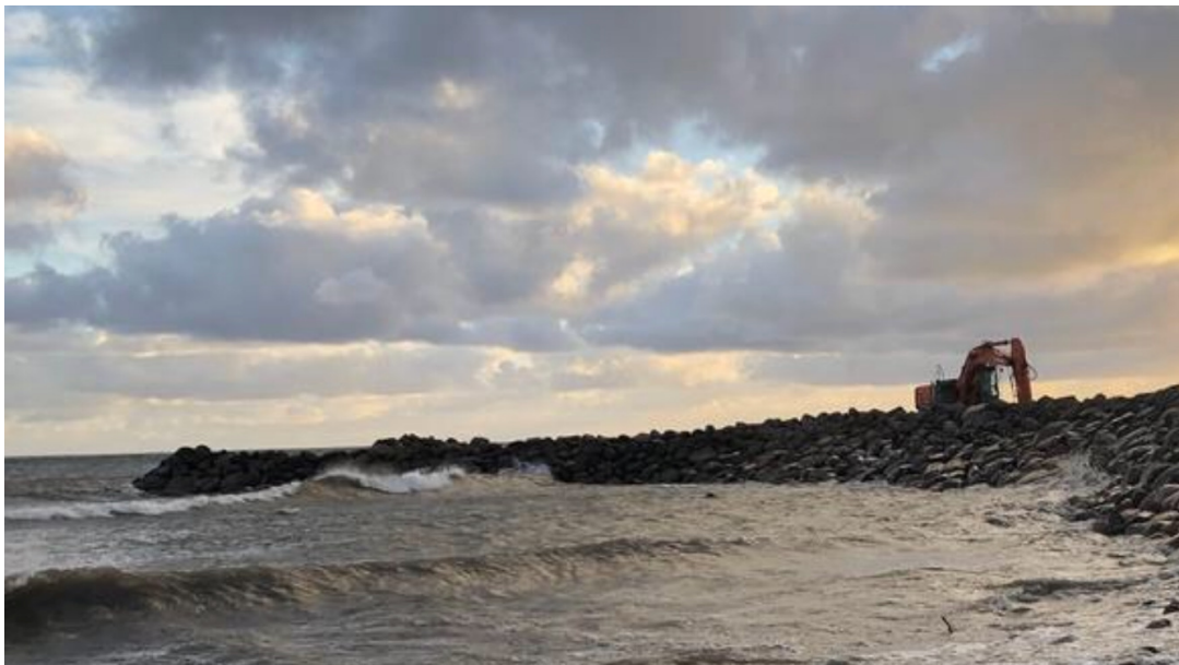
Foto 2 Vaade kaile nr 1 (Põhjakai).
