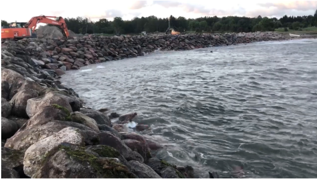
Foto 1 Vaade kaile nr 1 (Põhjakai).
