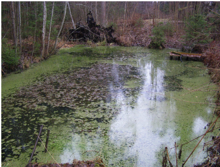
JOONIS 9. Ala 147 kirdenurgas asuv tiik (Metsa tänava äärne). Kinni kasvanud, veest ulatuvad välja raudtorud ning servas on katkine sillake. Tiik kasvab äärtest kinni ning tiigi serva on ladustatud komposti.
