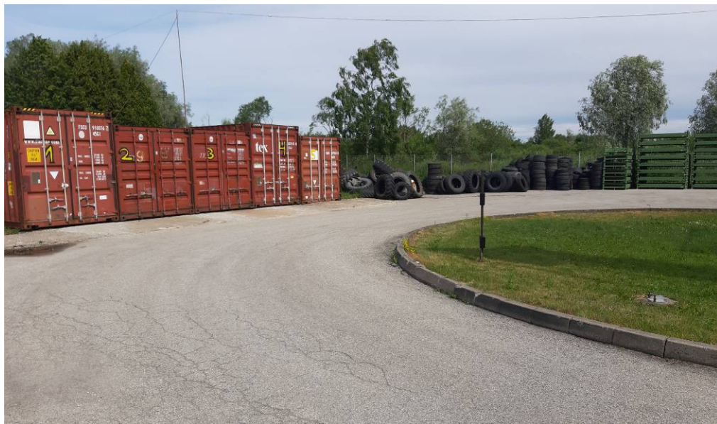
Foto 2.5. Vaade põhja suunas hoone laienduse osale krundi lääneküljelt. (03.07.2019).
