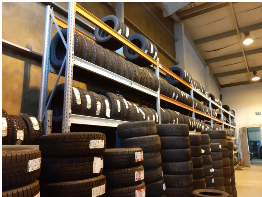
Foto 2.7. Vaade kirdesse hoone sees. Sein on seespool voorderdatud kivivillaga ning osaliselt kaetud ka kipsplaadiga ja tulekindla tuuletõkkega (01.10.2019).
