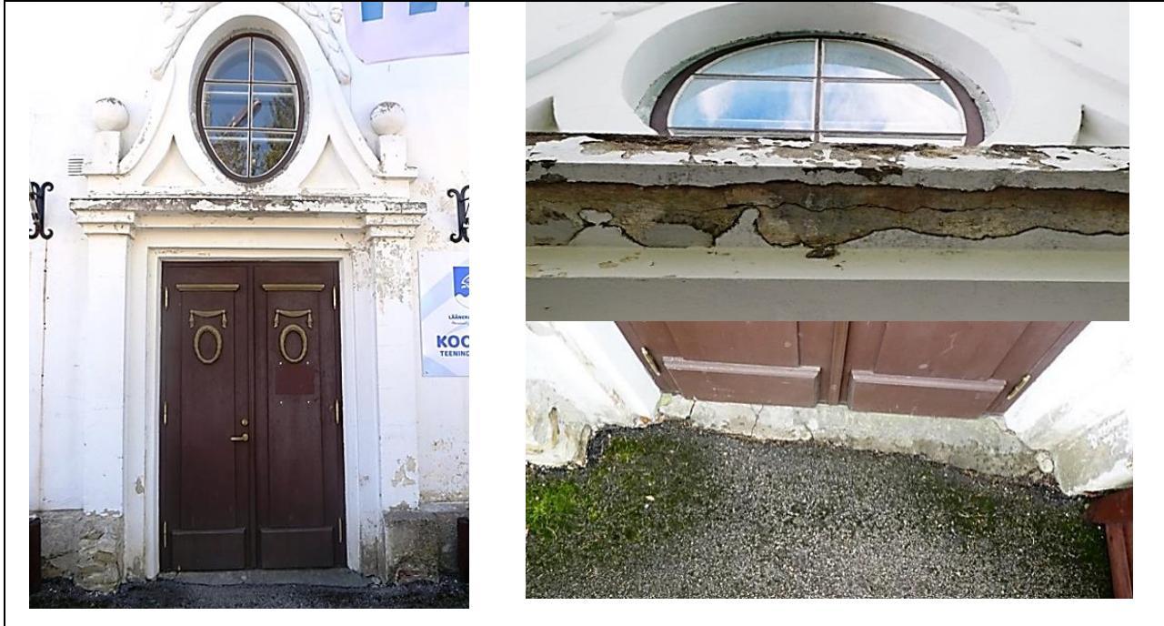
Fotod 1, 2, 3 Peauks koos portaaliga. Portaali ülaser (betoon) ja sokkel (paekivi) lagunevad. Perearstikeskuse avamiseks on vajalik teha järgmised tööd – vt. muinsuskaitse eritingimustes Punkt : 9.5.6.
