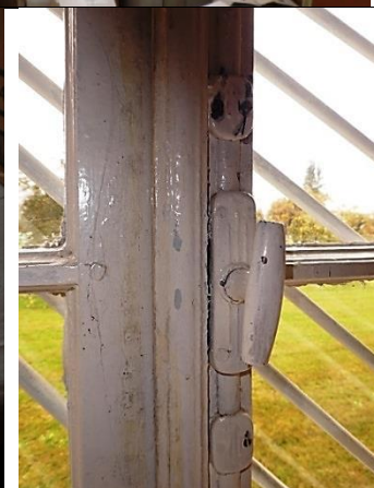
Foto 25, 26 ja 27 Olemasolevad aknalauad vajavad restaureerimist, kuid mitte kõigil ei ole säilinud esiserva profiili, mis on märgatav fotol. Olemasolevad kremoonid ei ole niivõrd halvas seisukorras, et neid ei saaks enam kasutada. Nende viie restaureerimist vajava akna puhul kremoonid säilitada, seejuures säilitada ja restaureerida peene profiiliga akna tuuleliist, sest kokku moodustub väga ilus kombinatsioon sobitatud detailidest. Fotol 27 – esifassaadi sisenurga aken on restaureeritud ja säilinud on ka originaalne vihmaveeplekk – tühjatraadi allapööratud esiserva ja ümaralt lõigatud küljpleki välisnurgaga.
