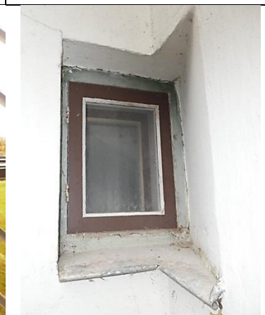
Foto 25, 26 ja 27 Olemasolevad aknalauad vajavad restaureerimist, kuid mitte kõigil ei ole säilinud esiserva profiili, mis on märgatav fotol. Olemasolevad kremoonid ei ole niivõrd halvas seisukorras, et neid ei saaks enam kasutada. Nende viie restaureerimist vajava akna puhul kremoonid säilitada, seejuures säilitada ja restaureerida peene profiiliga akna tuuleliist, sest kokku moodustub väga ilus kombinatsioon sobitatud detailidest. Fotol 27 – esifassaadi sisenurga aken on restaureeritud ja säilinud on ka originaalne vihmaveeplekk – tühjatraadi allapööratud esiserva ja ümaralt lõigatud küljpleki välisnurgaga.
