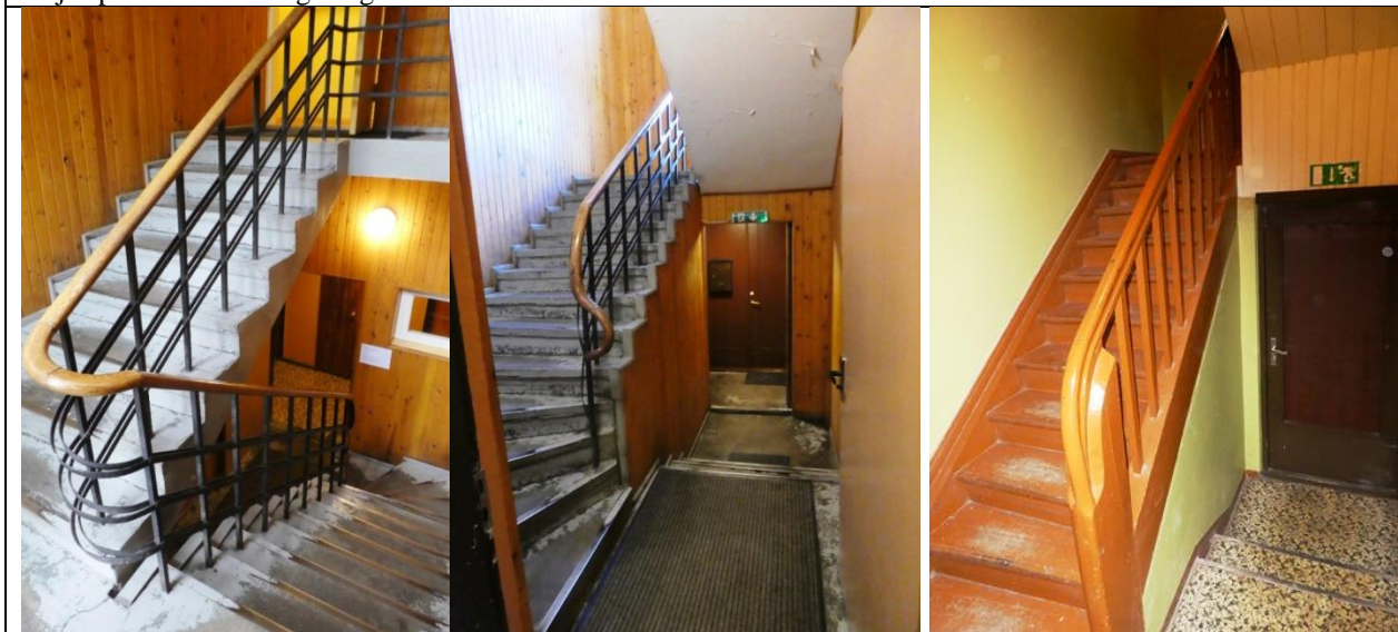
Foto 11 ja 12. Vaated peatrepikojas. Kohe võib öelda, et vesialuseline värv, nõukogude ajal oli see lateks-värv, lubjatud pinnale ei taha hästi jääda. Vastavalt tuleohutusnõuetele tuleb laudis seintelt eemaldada. Käesoleva projektiga teostatakse töö vaid esimese korruse ulatuses. Foto 13. Vaade puidust trepile teises trepikojas.
