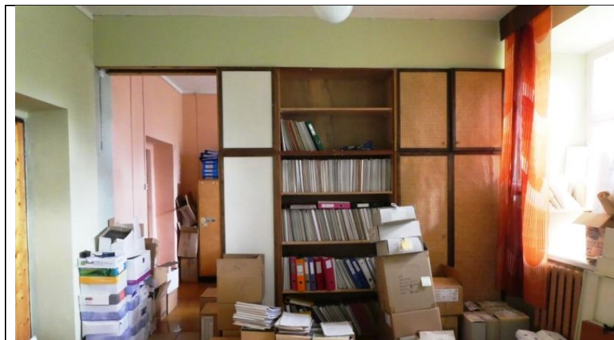
Foto 24 Vaade lõunapoolsete akendega ruumis, kuhu on kavas paigutada apteeži müügisaali vahesein fotol roosa ja rohelise ruumi vahele peab tulema R60, kuid kahju on utiliseerida spoonitud puitkilpe, mis on täiesti korras. Olemasolevad ukseavad ruumides on hilisemad, kuid sobivad ka uude ruumilahendusse. Uksepiidad aga paigaldatakse avades ruumi poole. Olemasolevad aknad vajavad restaureerimist.
