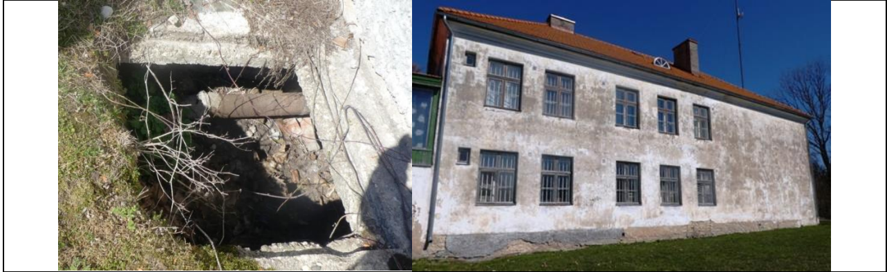
Foto 6 ja 7. Uue vee ja kanalisatsioonisüsteemi paigaldajal kontrollida, mis auk see selline on. Enne oli see kuivkäimla auk, kuid nüüd tuleb siit läbi välisseina ka vee- ning kanalisatsiooni sisend. Tööd tuleb lõpetada vastavalt tehnilistele tingimustele. Sõlm tuleb vajadusel soojustada ja katta avatava luugiga.
