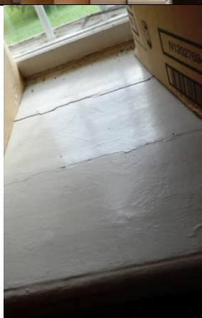
Foto 25, 26 ja 27 Olemasolevad aknalauad vajavad restaureerimist, kuid mitte kõigil ei ole säilinud esiserva profiili, mis on märgatav fotol. Olemasolevad kremoonid ei ole niivõrd halvas seisukorras, et neid ei saaks enam kasutada. Nende viie restaureerimist vajava akna puhul kremoonid säilitada, seejuures säilitada ja restaureerida peene profiiliga akna tuuleliist, sest kokku moodustub väga ilus kombinatsioon sobitatud detailidest. Fotol 27 – esifassaadi sisenurga aken on restaureeritud ja säilinud on ka originaalne vihmaveeplekk – tühjatraadi allapööratud esiserva ja ümaralt lõigatud küljpleki välisnurgaga.
