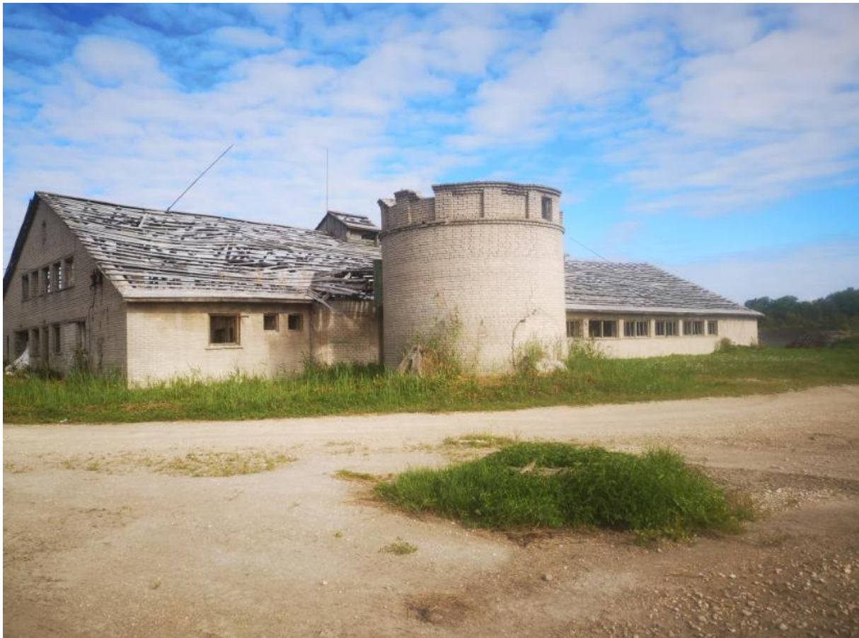
Foto 1. Lammutatavad lauda konstruksioonid
