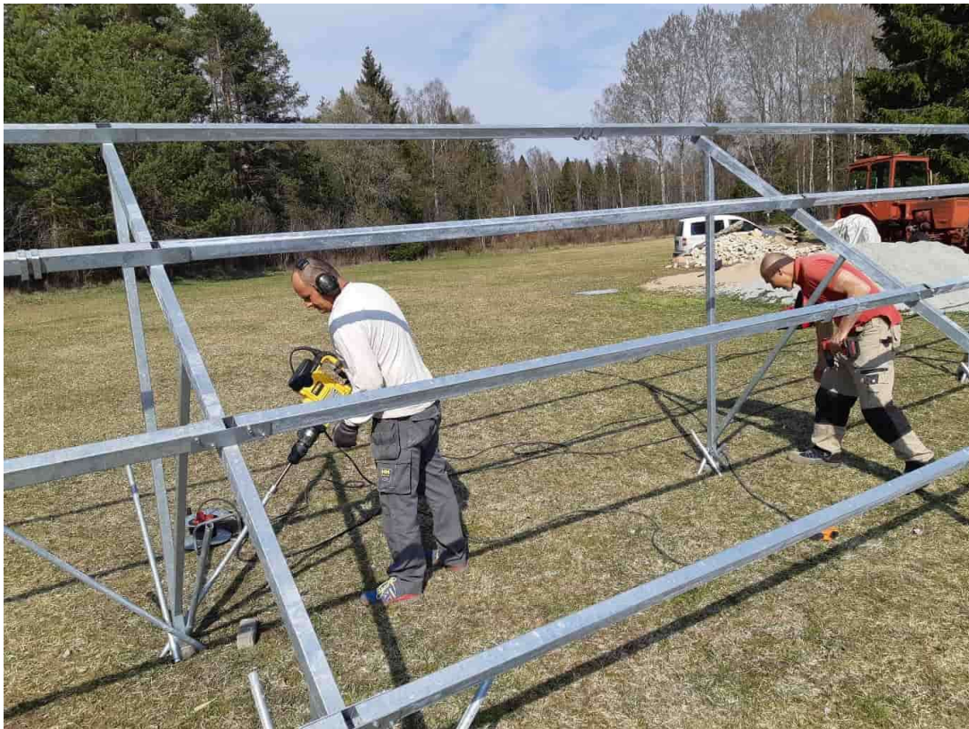
Taastuenergia OÜ maaraami TreeSystem paigaldamine 2019
