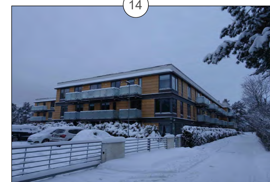
Põllu 63a pansionaat
