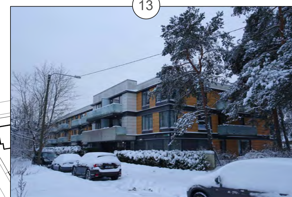
Põllu 63a pansionaat
