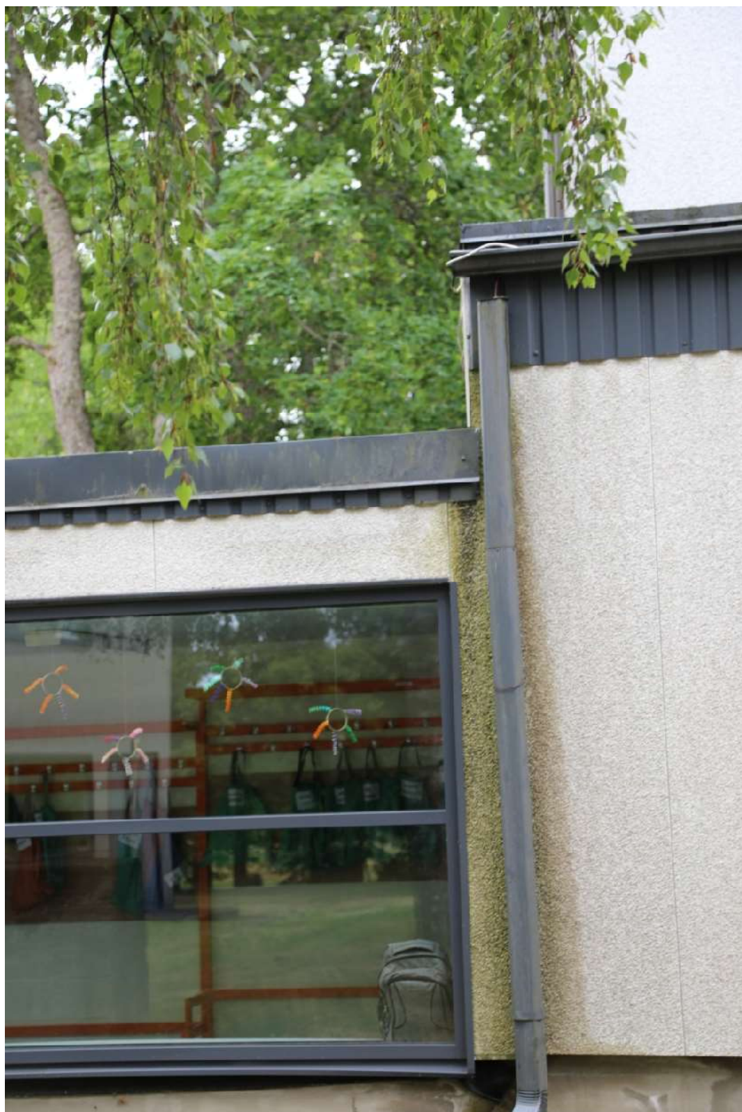
Foto 11. Vaade vahekoridorile sisehoovi poolt. Vihmaveetoru on olnud pikemat aega renni küljest lahti ja kahjustanud fassaadi.
