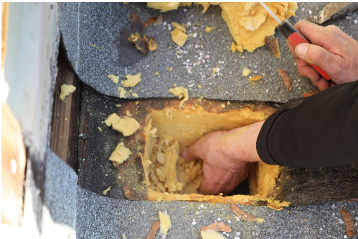
Foto 14. Avatud katus on soojustatud jäiga mineraalvillaga.
