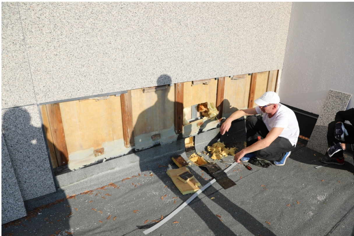
Foto 13. Koridori katuse avamine.
