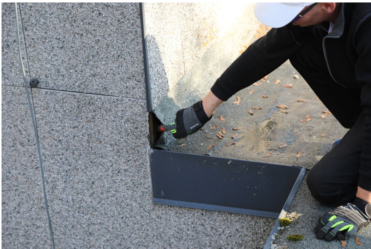
Foto 12 . Seinale tehtud hüdroisolatsiooni ülespõre on aluselt lahti.
