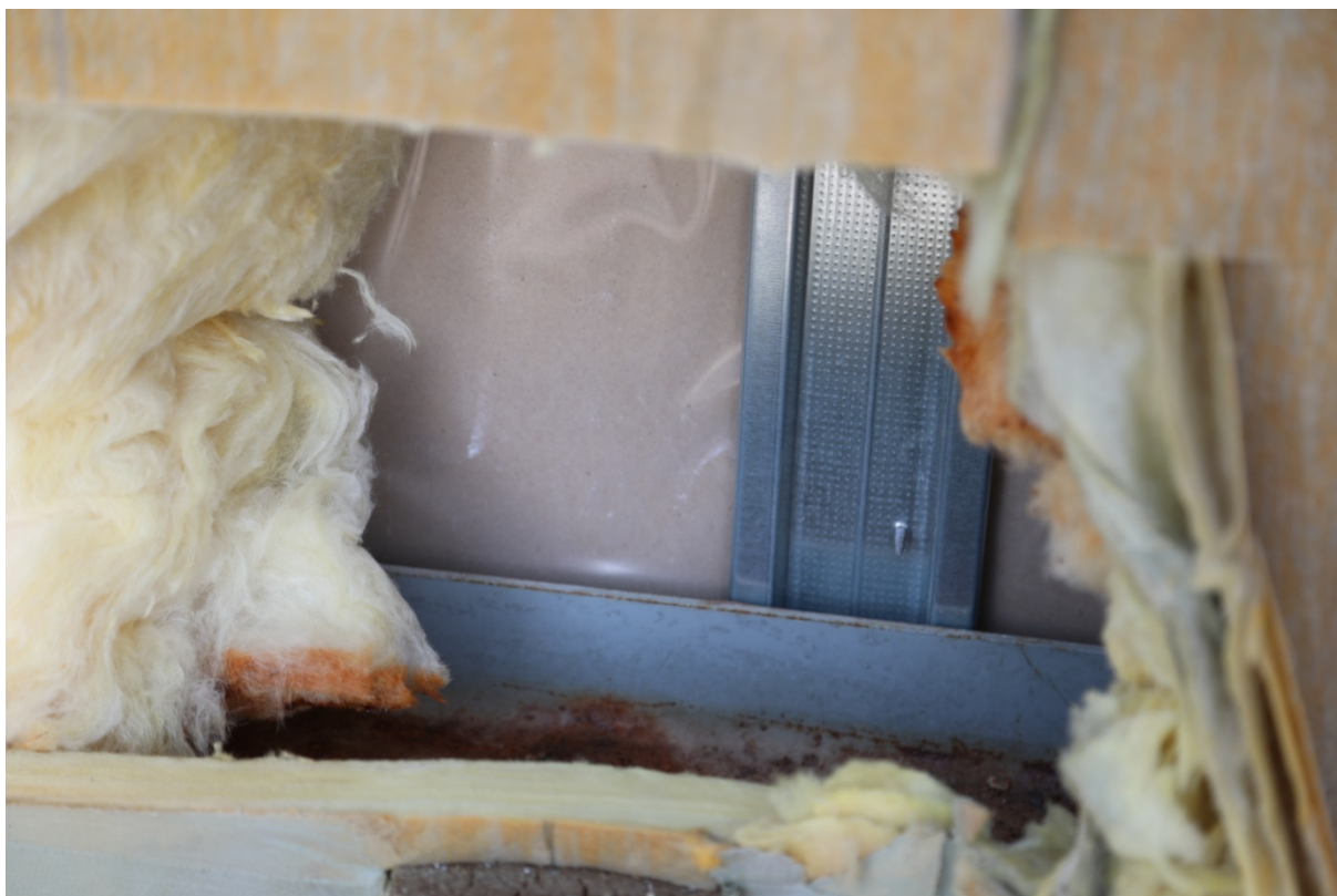
Foto 11. Sein on metallroovidest kandeosaga, millele kinnitub kipsplaat ja puitroovitus. Seinal on kileaurutõke.
