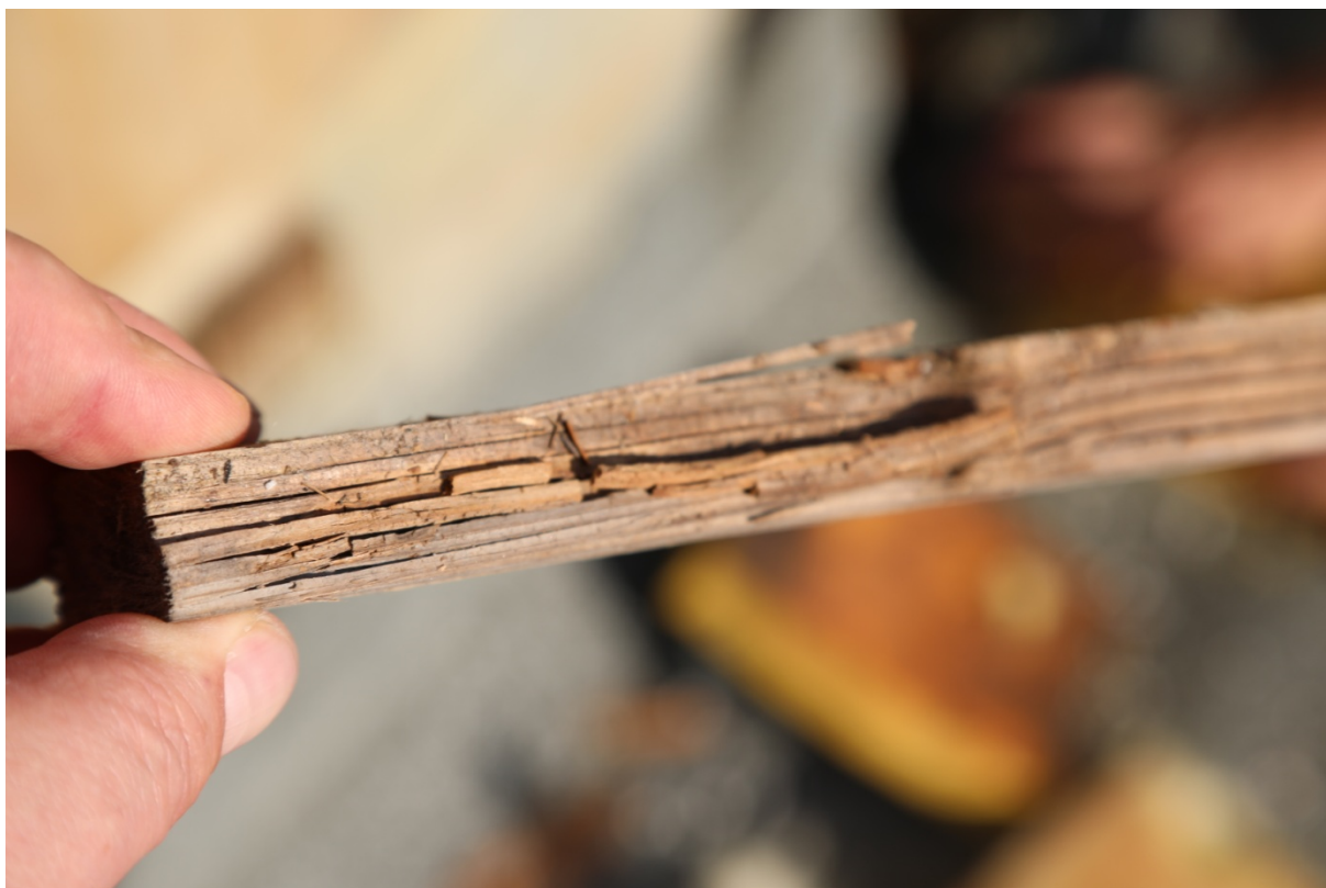
Foto 16. Seina puitroov on osaliselt fassaadi sattunud sademeveest kahjustunud.
