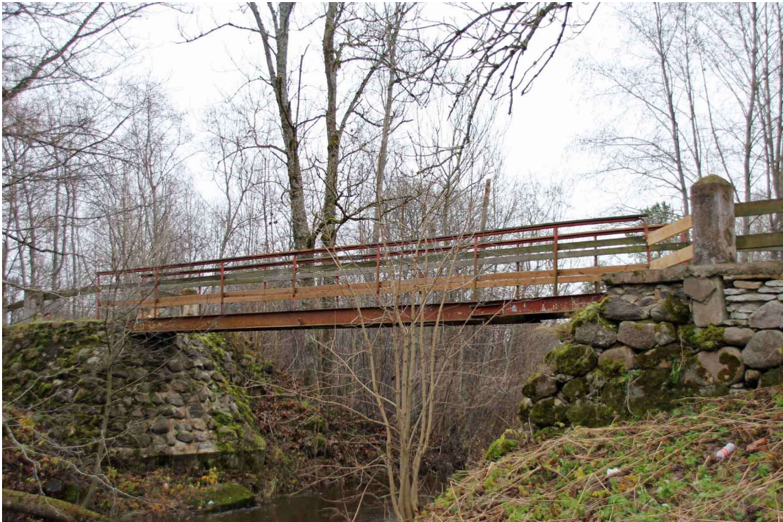
Foto 3. 13 m pikkuse silla üldvaade. Vasakul näha kindlustatud koonus. Parempoolne tugi on algse sillasamba lagunenu jäänustel.
