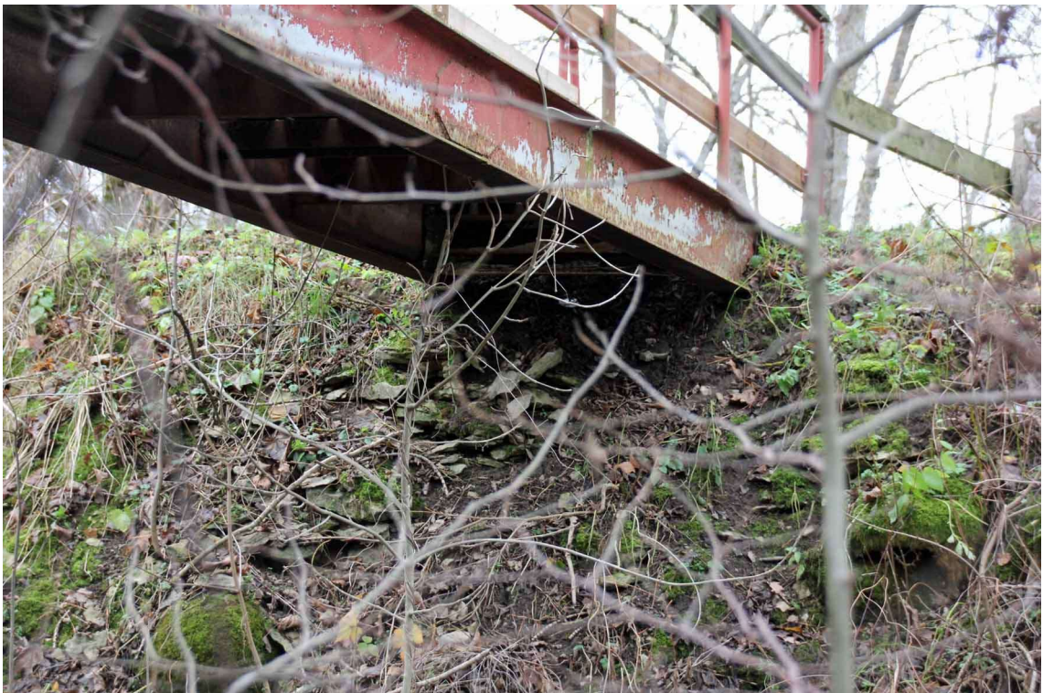
Foto 10. 15 m silla saare poolne tugi. Praktiliselt sama, mis lühema silla maapoolne tugi, kuid oluliselt laugema nõlvaga. Siiski vajab nõlv püsivuse tagamiseks kaitset.
