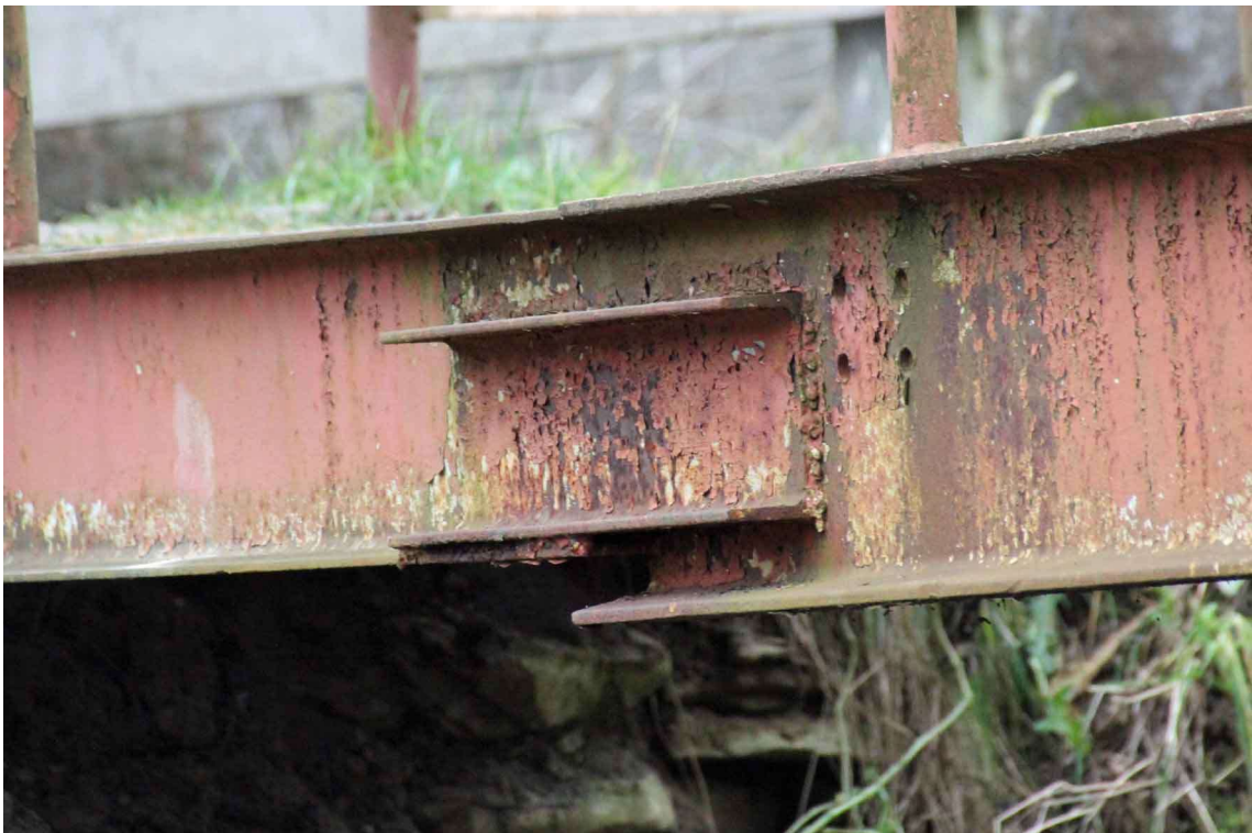
Foto 6. Erineva profiiliga talade jätk karpterasega. Analoogne lahendus silla mõlemal küljel. Sillatala säilitamise korral on liide vaja koostada uuesti vastavalt nõuetele ja juhistele.
