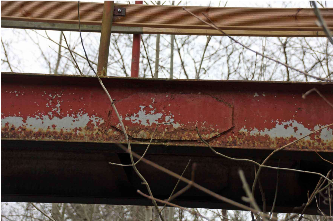
Foto 11. Suhteliselt korrektselt teostatud 15 m silla talade jätk. Sarnane jätkulahendus on silla mõlemal küljel.
