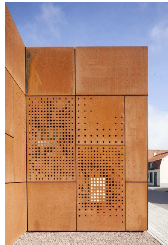
Iseloomulik ja meeldejäävate CORTEN PANEELIDEGA kaetud olemasoleva hoone osa - väga minimaalset hooldust vajavad. Paneelide taga fassaad krohvitud tumedaks.
