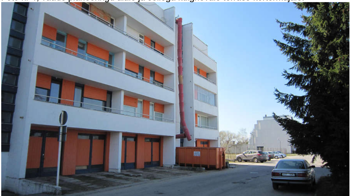
Foto nr 2, kirdepoolne vaade olemasolevale terrass-majale.
