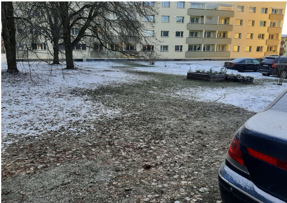
Foto 5. Käärdi soojustrasside soojuskadude iseloomustav vaade
