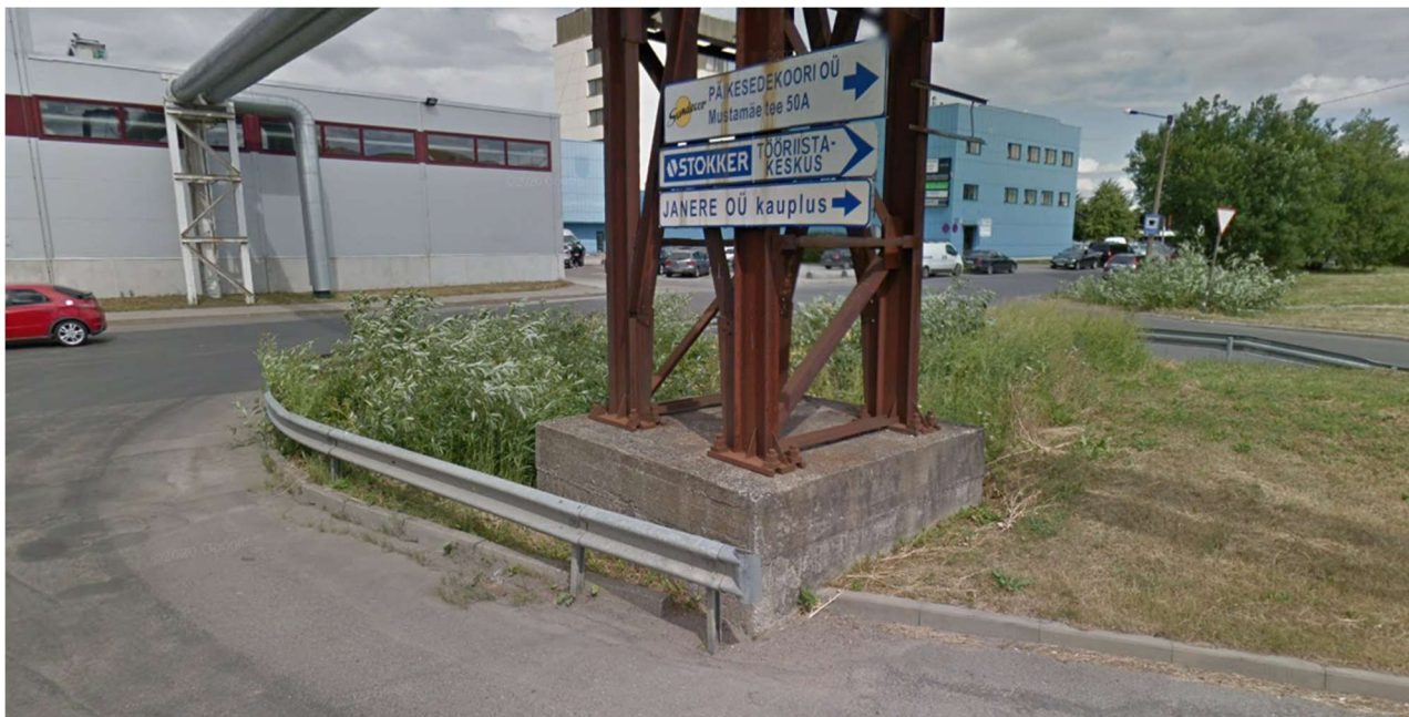
Foto nr 7: Soojatorustiku kandemasti vundament Laki tn - Forelli tn ristmiku ohutussaarel (Google Streetview juuli 2019).
