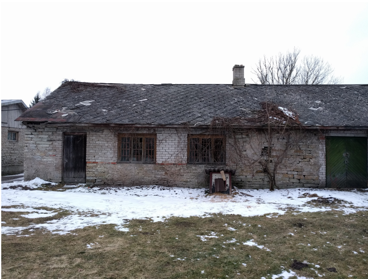
Foto abihoonest, foto autor Arhitektuuribüroo TAVA
