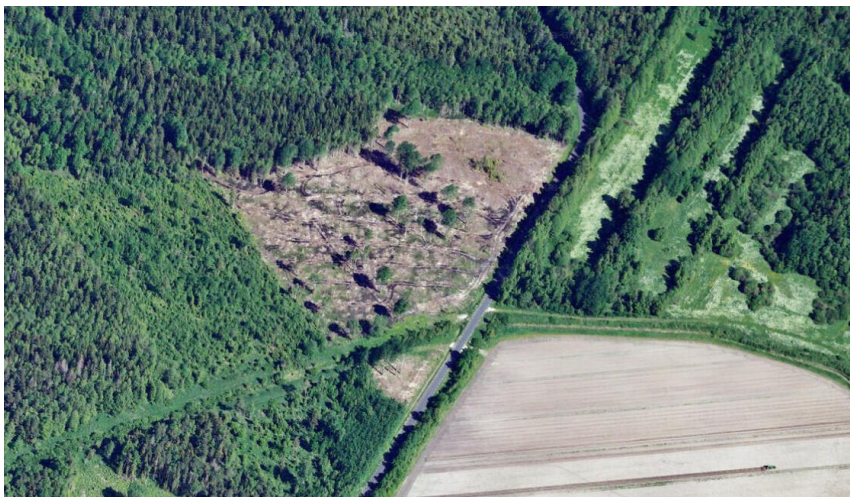
Joonis 3. Vaade Altküla asukohaalternatiivi maa-alale. Foto: Maa-amet fotoladu, 6.2022.
